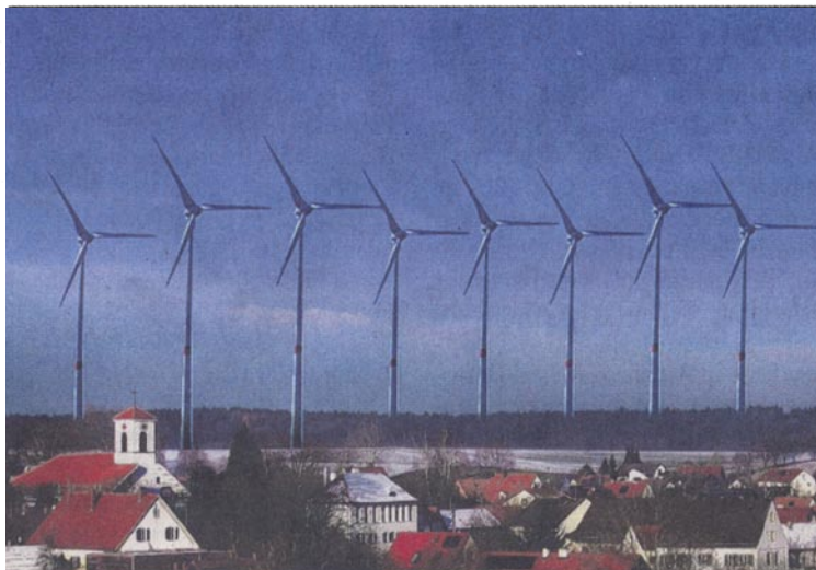
180 Meter hoch würden die Windräder im Erlauholz über den Stadtteil Bachern aufragen. Die Bürgerinitiative stellt dies in einer Fotomontage dar. Bild: privat
